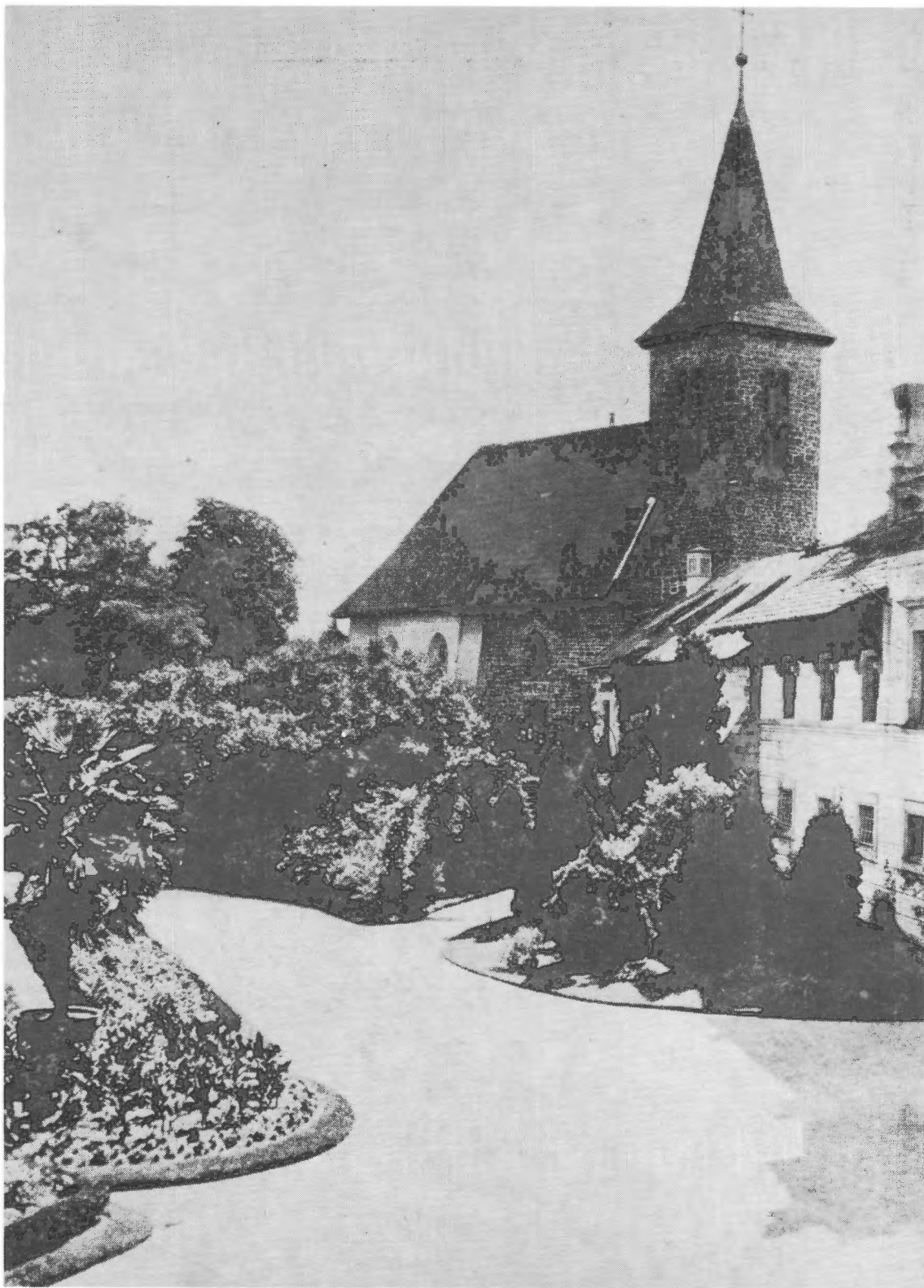
obr. 35 / 1 / Nádvoří před zámkem a kostelíkem
